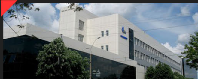
Офисный центр "IPVA"
