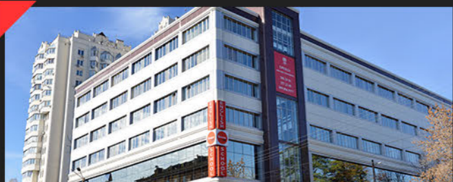
Офисный центр "Стенд"
